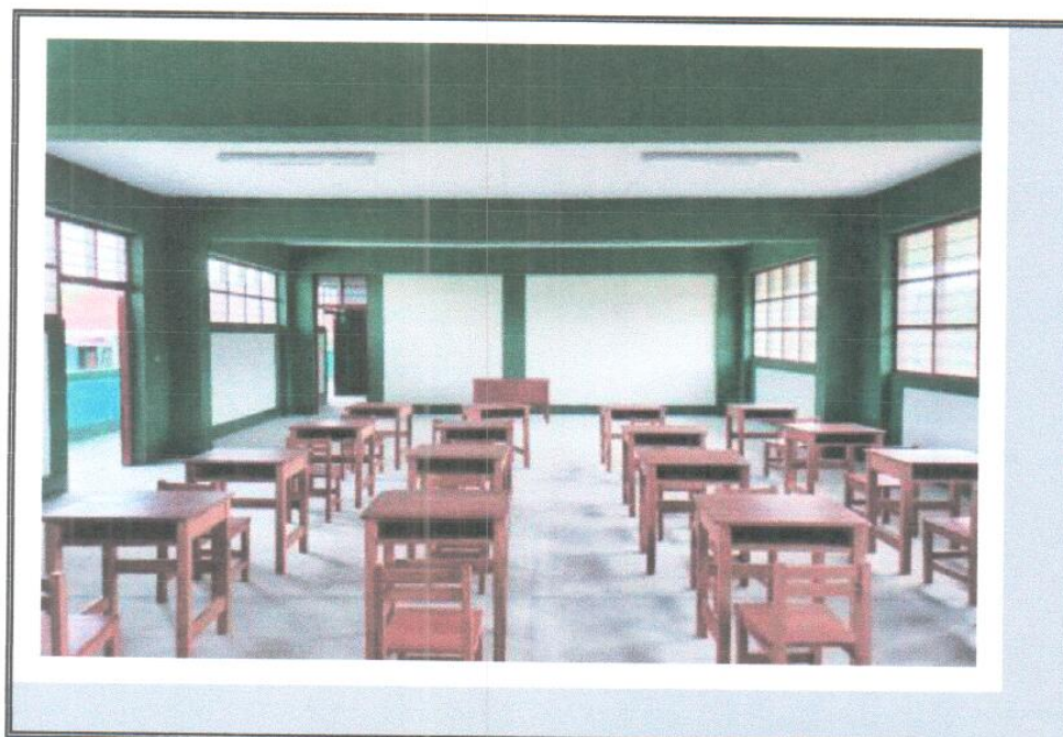
VISTA DE LOS TRABAJOS CULMINADOS Y MOBILIARIOS..
