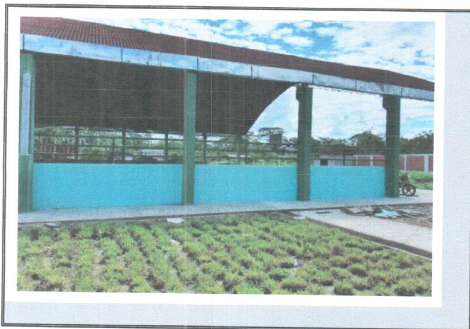
VISTA DE LOS TRABAJOS CUMINADOS EN LA LOSA DEPORTIVA.
