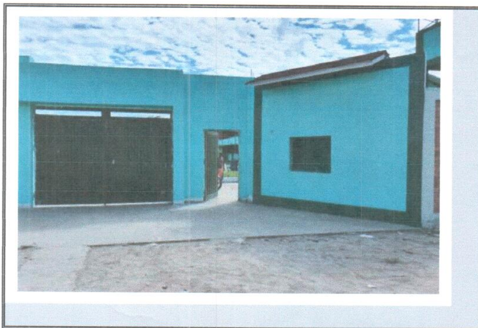
VISTA DE LOS TRABAJOS CULMINADOS EN LA FACHADA DEL COLEGIO.
