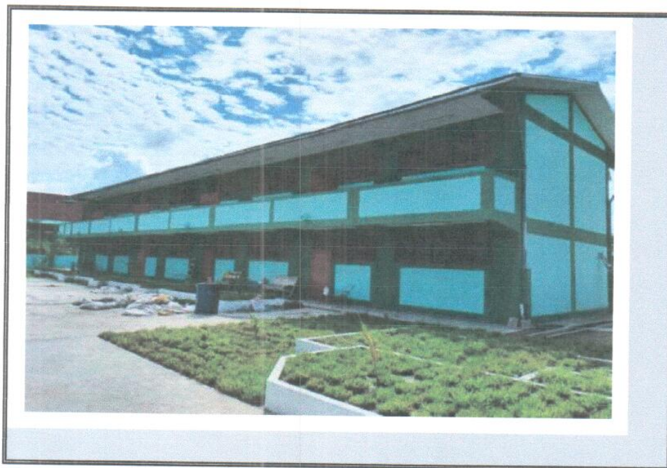
VISTA DE LA CULMINACION DE LOS TRABAJOS PATIO Y JARDINERIA.
