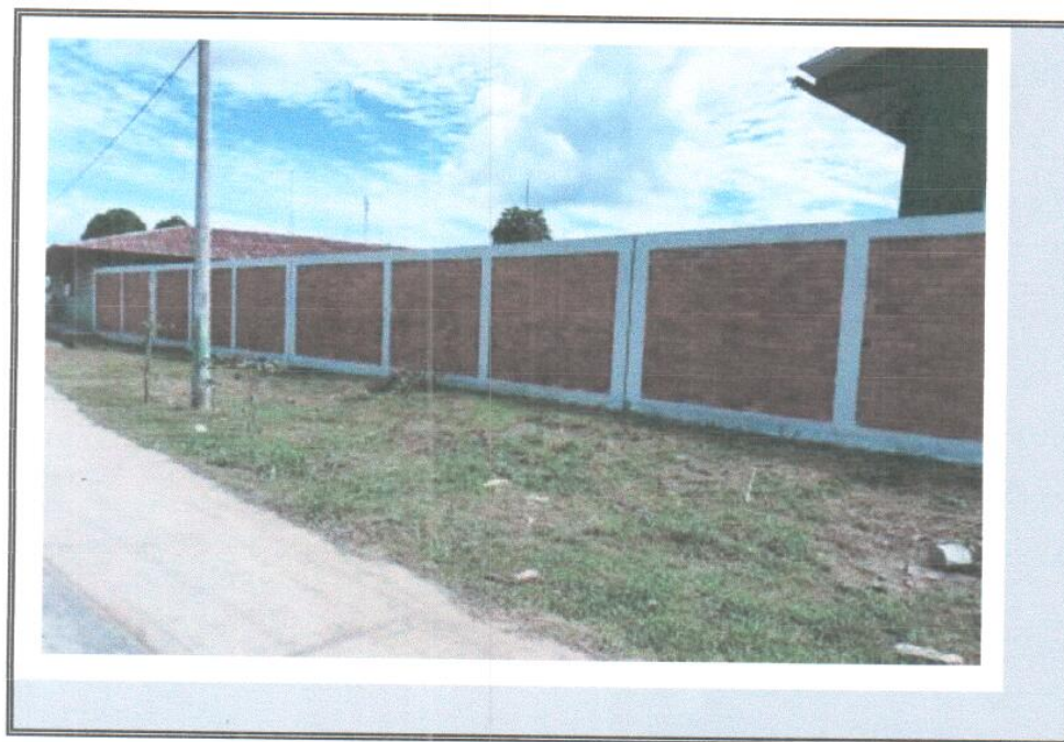
VISTA DE LOS TRABAJOS CULMINADOS Y LIMPIEZA DE LA OBRA CERCO PERIMETRICO.
