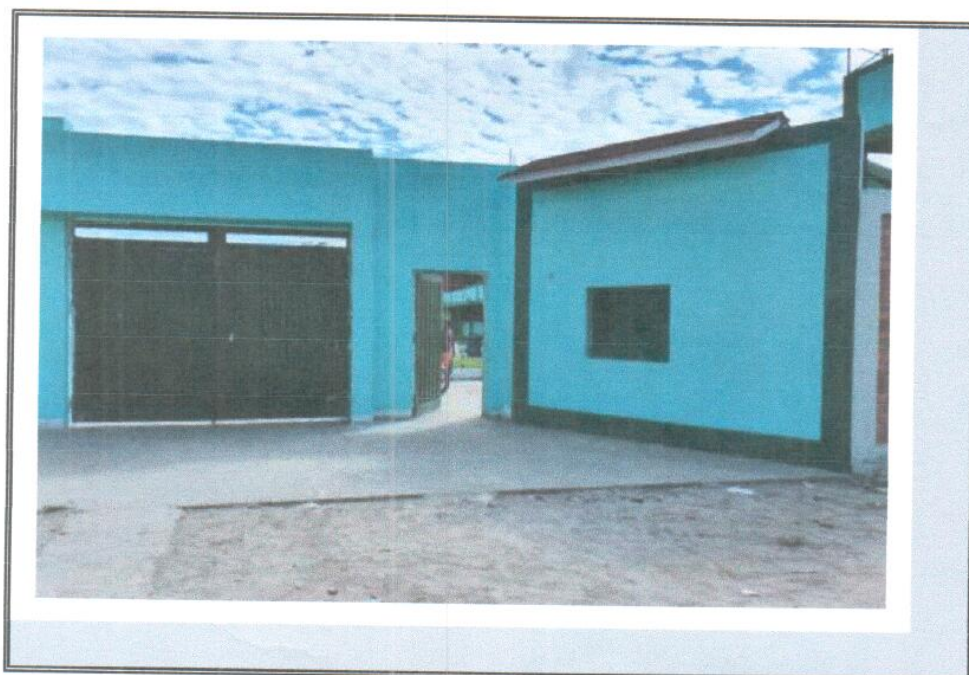
VISTA DE LOS TRABAJOS CULMINADOS EN LA FACHADA DEL COLEGIO.
