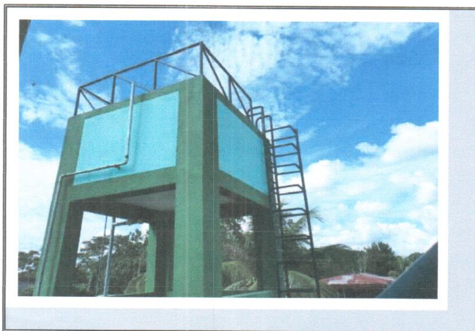
VISTA DE LOS TRABAJOS CULMINADOS EN EL TANQUE ELEVADO
