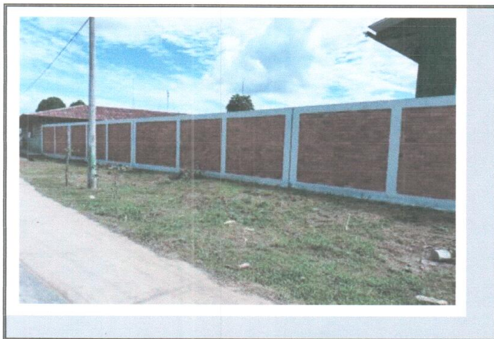
VISTA DE LOS TRABAJOS CULMINADOS Y LIMPIEZA DE LA OBRA CERCO PERIMETRICO.
