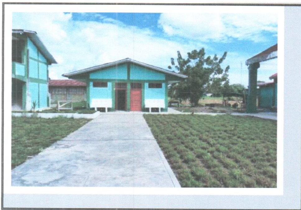
VISTA DE LOS TRABAJOS CULMINADOS EN EL MIDULO DE SS.HH..
