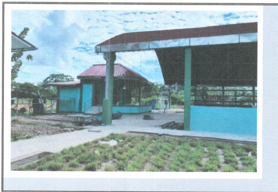
VISTA DE LOS TRABAJOS CULMINADOS DEL ESCENARIO.
